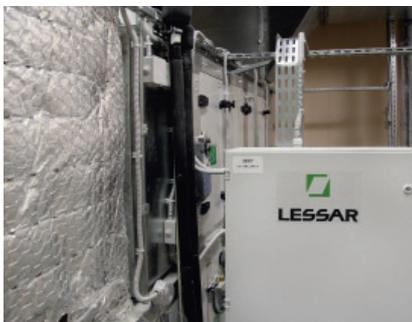
Контроллер фреоновых секций приточных установок LZ-AHU позволяет подключить фреоновую секцию приточной вентустановки к наружному блоку мультizonальной системы LMV. Контроллер позволяет работать с одноконтурной системой до 45 кВт, с двухконтурной системой до 90 кВт.
